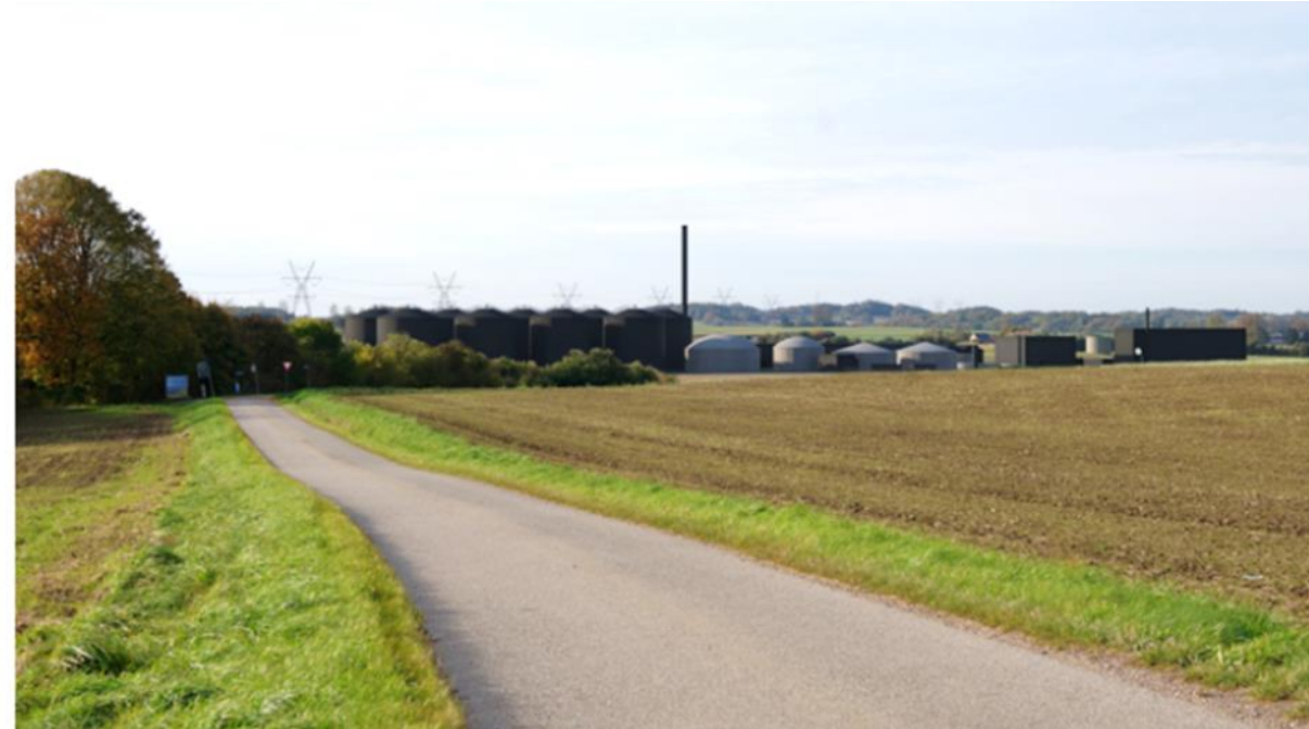
Niras billede i Miljørapport Nature Energy 2024 Standpunkt 8 Fra Vandværksvej ved Torrild Byskilt ca. 900 meter væk Biomasseoplag ca. 1,2 mill. tons biomasse årligt 9 rådnetanke
